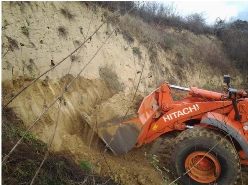
Abb. 12: Entfernung des abgerutschten Materials am Böschungsfuss Nov. 2012
