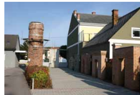
■ Dorferneuerungsprojekt Neutal – Zubau MUBA Foto: Steindy
