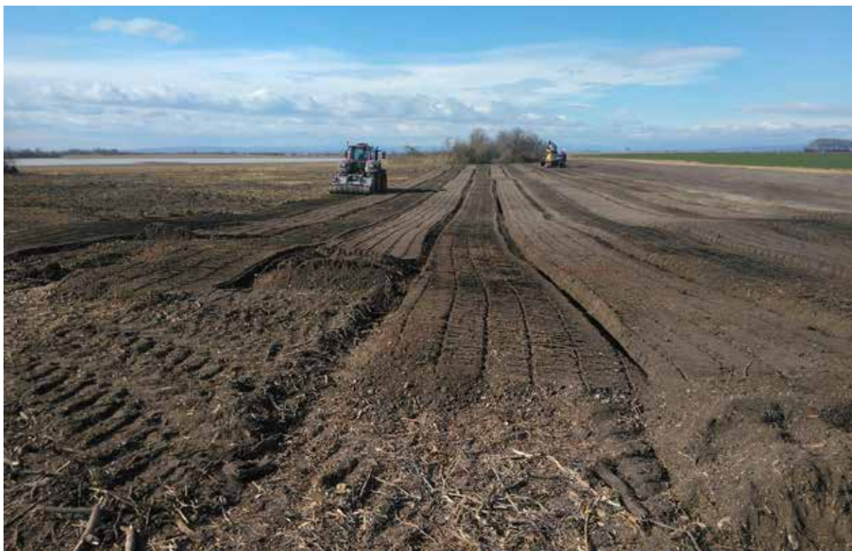
Abbildung 120: Arbeiten mit Tiefenfräse in der Bewahrungszone Illmitz - Hölle (Archiv Nationalpark Neusiedler See)
