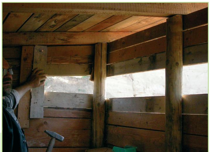
Abb. 4 und 5: Bauliche Maßnahme zur Einengung der Beobachtungsöffnung, um die Deckung der Besucher zu erhöhen und dadurch die Beunruhigung der Vögel möglichst gering zu halten.
