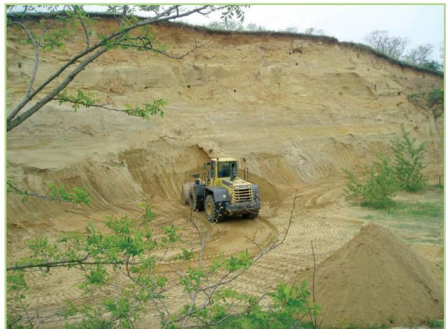
*Abb. 7: Bagger bei der Entfernung des abgerutschten Materials.*
