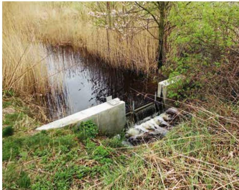
263/5: Halbherziger Rückstau des Scheibenlackenkanals – zur Sanierung der Lacke ist dieser Kanal komplett zu verfüllen! (6. März 2010)
