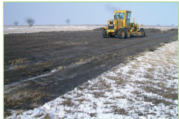
Abb. 2.7: Entfernung der Wiesenvegetation mittels eines Gräders (Firma Alois Steiner, Illmitz) auf einer Versuchsfläche von 600 m 2 in der Kleinen Martinhoflacke bei gefrorenem Boden im Februar 2005.
