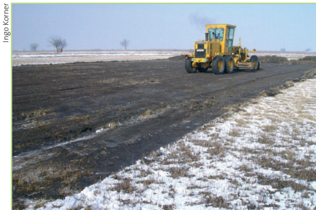
Abb. 5.53: Abschieben des Oberbodens mit dem Gräder.
