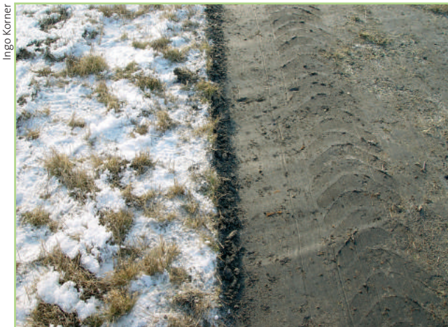
Abb. 5.22: Abschieben des humusreichen Oberbodens bei starkem Frost.
