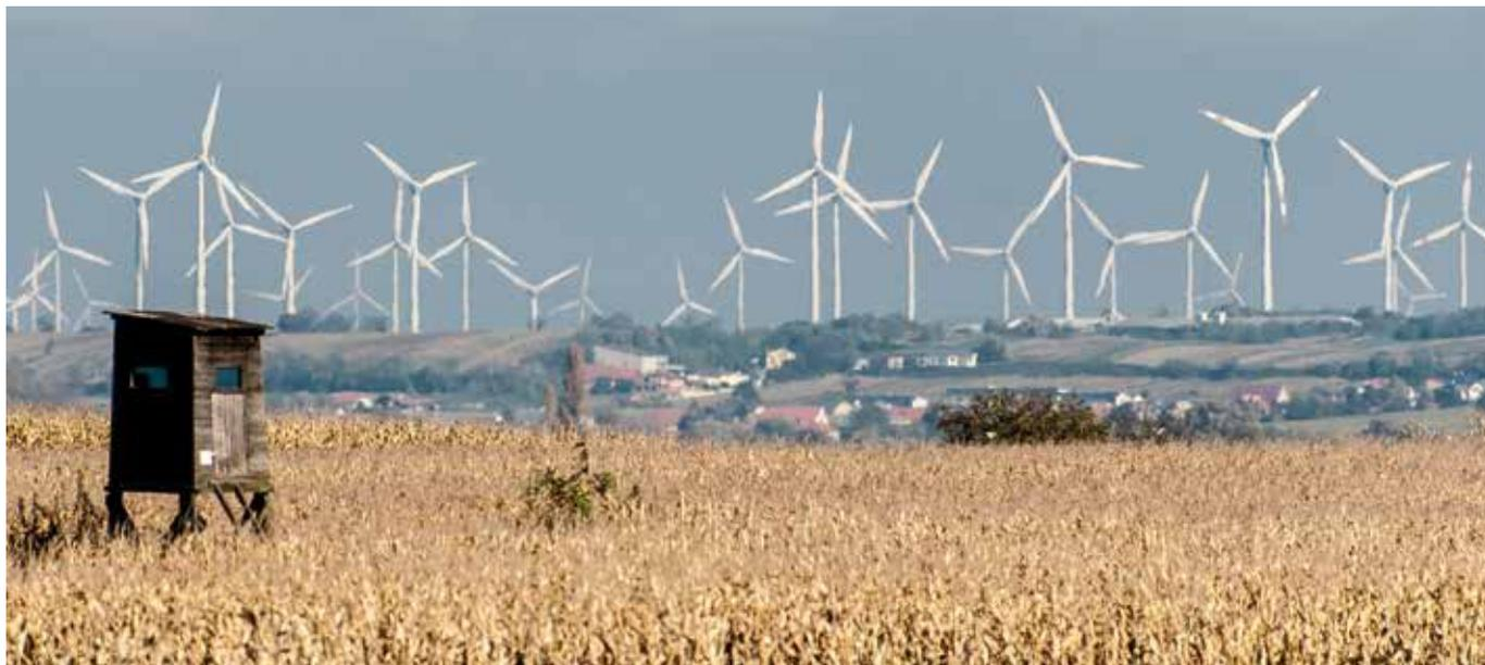
■ **Bestehende Windkraftanlagen – oben Windpark bei Neusiedl am See – eignen sich für die Einrichtung sogenannter Hybridanlagen, da diese die vorhandene Einspeise-Infrastruktur ideal nützen können.** Foto: © Energie Burgenland
